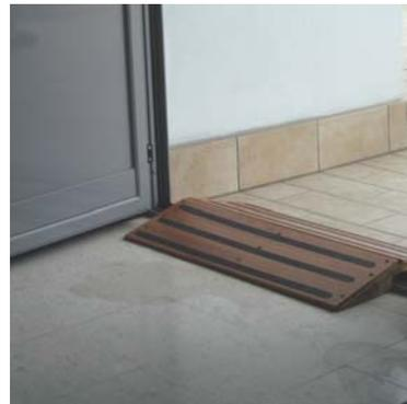
Particolare di una doppia rampa per superare la battuta di un serramento in alluminio
