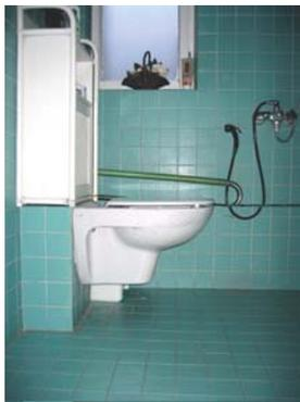
✓ Esempio di corretto utilizzo del wc sia per l'altezza del sanitario da terra (43 cm) sia per l'impiego del modello standard sospeso. La collocazione del mobile dietro la tazza consente l'opportuno appoggio del coperchio del wc e la conseguente possibilità di appoggiare la schiena in posizione verticale. La doccetta posizionata a lato del sanitario consente l'appropriato utilizzo della stessa.
