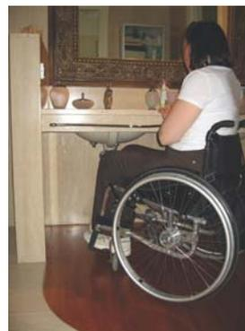
✓ Esempio di corretto utilizzo dei lavabi che sono di tipo standard, con rubinetti con miscelatore a leva normale. Gli scarichi sono a parete e posizionati ad un'altezza utile per consentire la manovra di avvicinamento.
