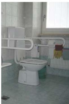
✓ Esempio di corretto utilizzo del wc sia per l'altezza del sanitario da terra (43 cm) sia per l'impiego del modello standard. La collocazione della cassetta-sciacquone consente l'opportuno appoggio del coperchio del wc e la conseguente possibilità di appoggiare la schiena in posizione verticale. I maniglioni, entrambi reclinabili, sono installati correttamente e permettono un agevole utilizzo del sanitario stesso.
